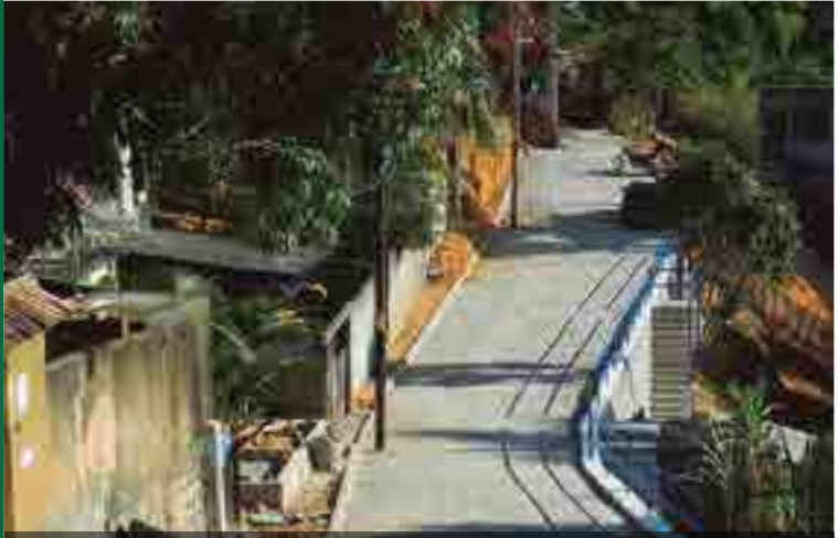
Drenagem, pavimentaço, construo de escadaria e muro
