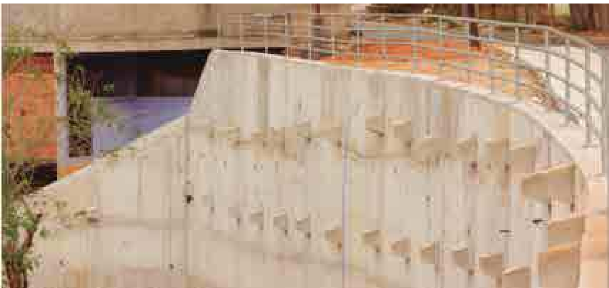
Muro de Contenç3o | Rua A em Universal
