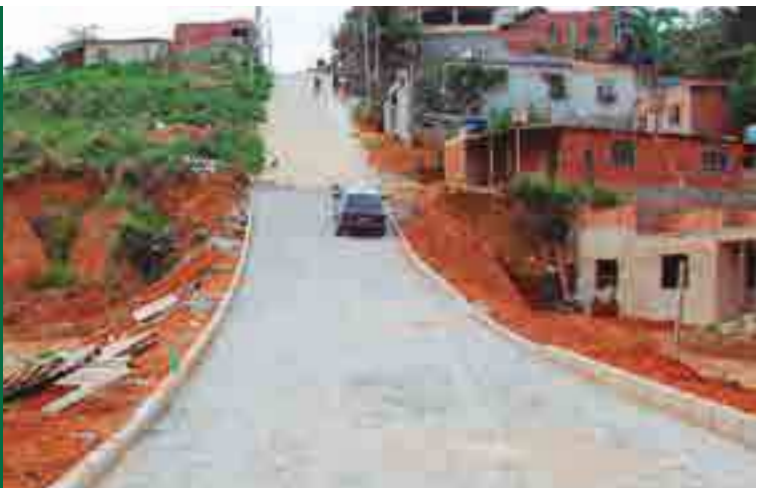
Reconstruo, drenagem e pavimentaço de via
