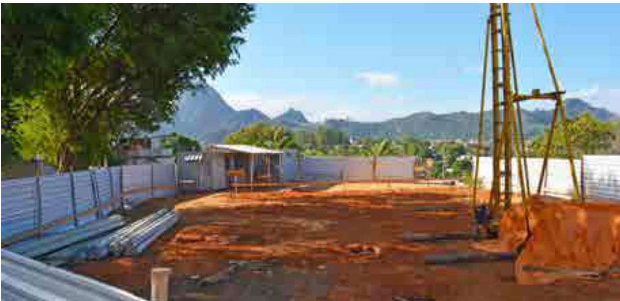
Canteiro de obra da US de Marclio de Noronha II
