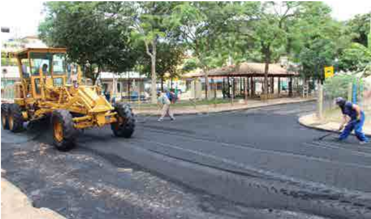
Pavimentação das ruas no entorno da Praça de Universal
