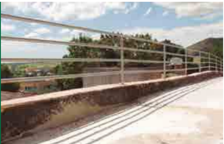
Construço de muro de arrimo
