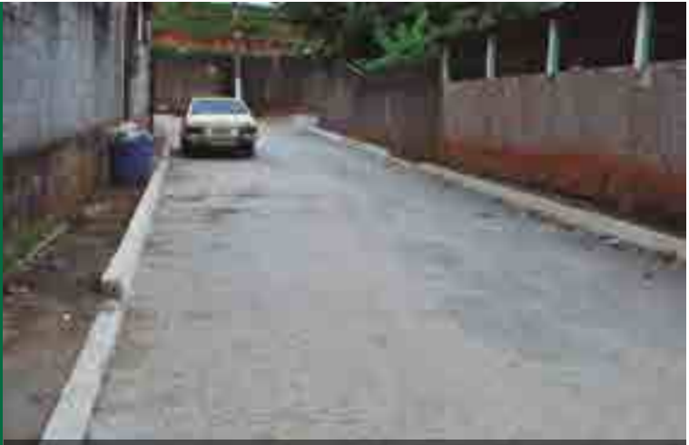
Drenagem e pavimentaço
