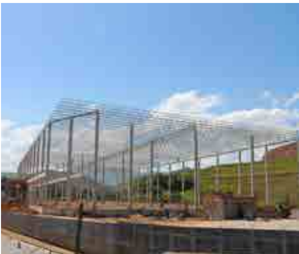
Galpão de logística no bairro Canaã
