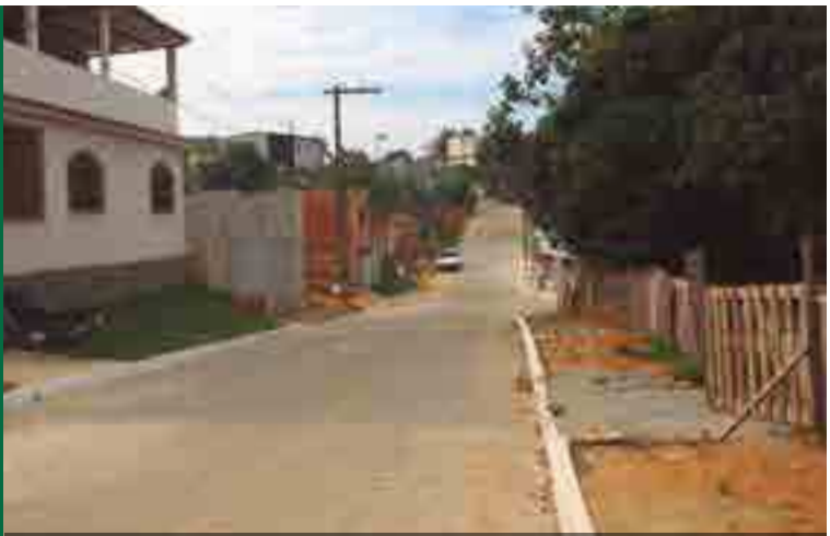
Drenagem e pavimentaço
