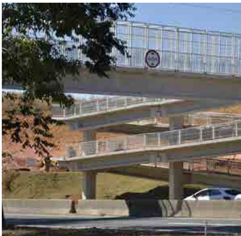
Uma das passarelas construídas | Bairro Canaã
